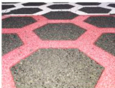
Pavimentación y señalación
