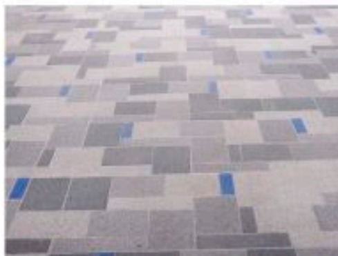
Pavimentación y señalación
