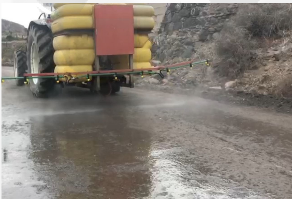
Fig. 2 Aplicando Zoruflex Mineralit
