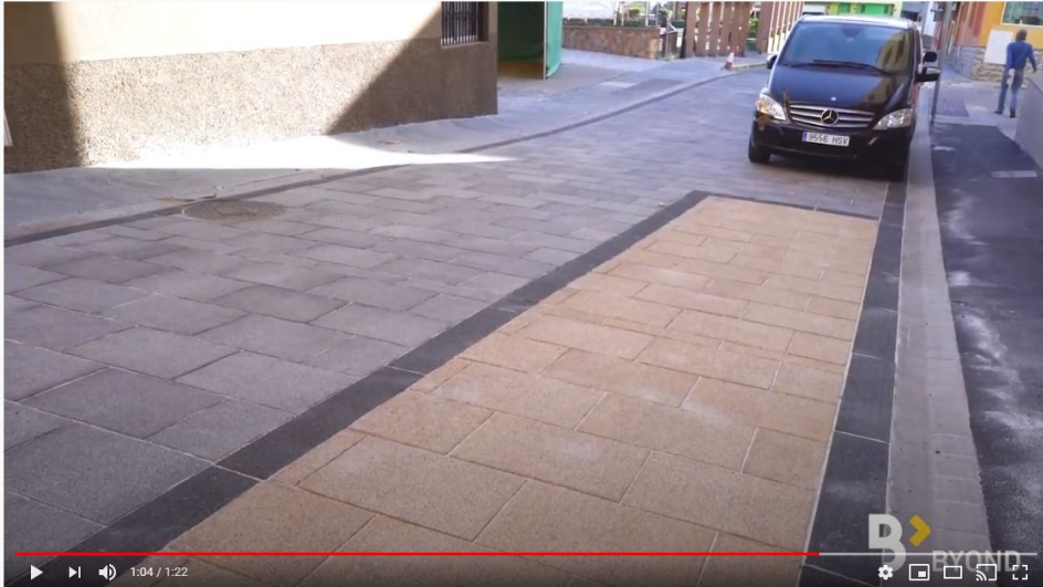
Nueva Repavimentación con el Sistema Preformado, en Valsequillo - Gran Canaria. Sistema Preformado es un pavimento de plaquetas fabricadas
