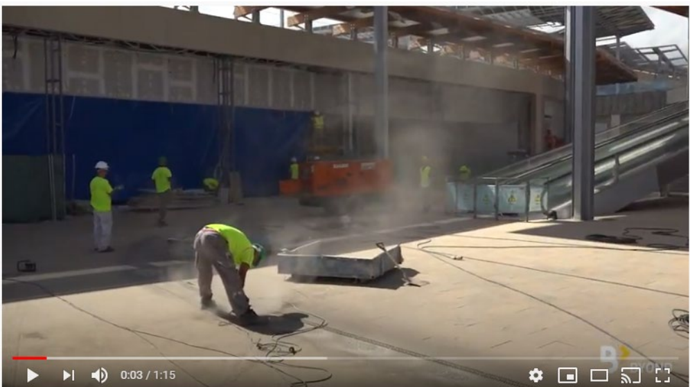
CENTRO COMERCIAL LOS ALISIOS – VIAL INTERIOR, ZORUFLEX ASFALTO PULIDO 4000 M2 y CALLE JUAN MANUEL DURAN 2000 M2
