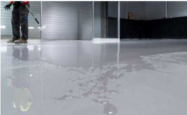
Los distintos acabados de Byopox Imprimación Anti-humedad sólo difieren en el color que está incorporado en el componente A. Los kits se presentan en lotes de 7 kgs. (comp. A 5,5 kg + comp. B 1,5 kg) ya teñidos.
